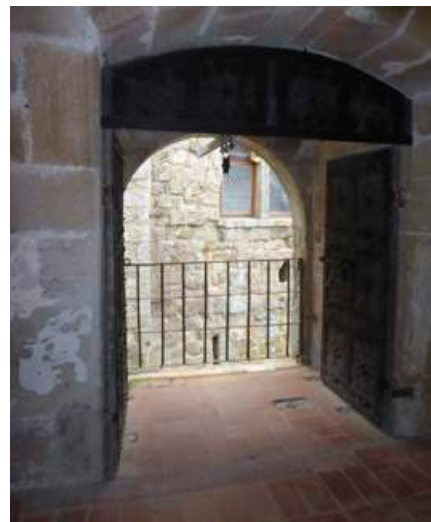
Fig. 16 : Vue depuis la salle haute de l'ébrasement de la porte du grenier du cellier et son intégration dans la voûte actuelle.
