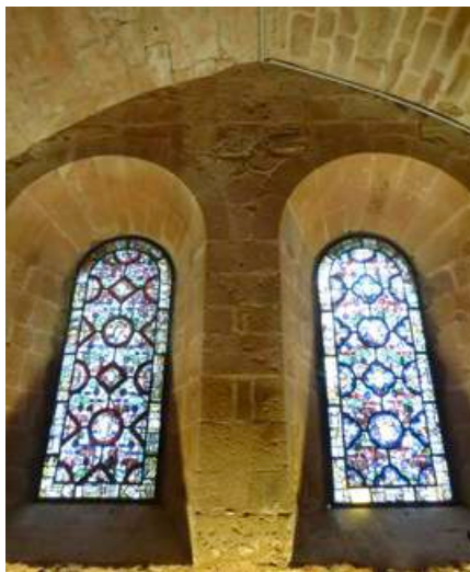
Fig. 15 : Détail des baies jumelles de la salle haute du cellier ainsi que du bouchement de la baie haute du pignon disparaissant dans le voûtement de la salle.
