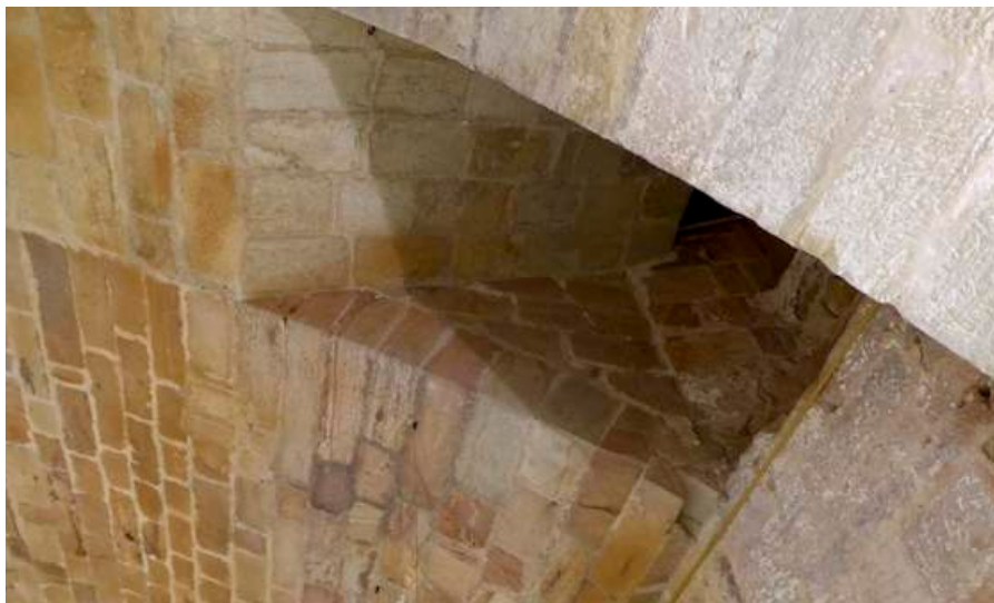
Fig. 31 : Détail du voûtement et de la lunette dégageant la baie médiane de la façade ouest du cellier.
