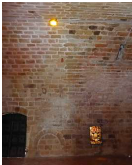
Fig. 32 : Détail de la ligne de décharge d'assises entre parties nord et sud de la voûte, à proximité de la porte du grenier. Le sommet de la baie médiane est muré au-dessous du sol de tomettes.
