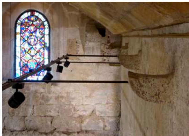
Fig. 30 : Vue des corbeaux de muraillère implantés sous le voûtement de la partie sud de la salle basse.
