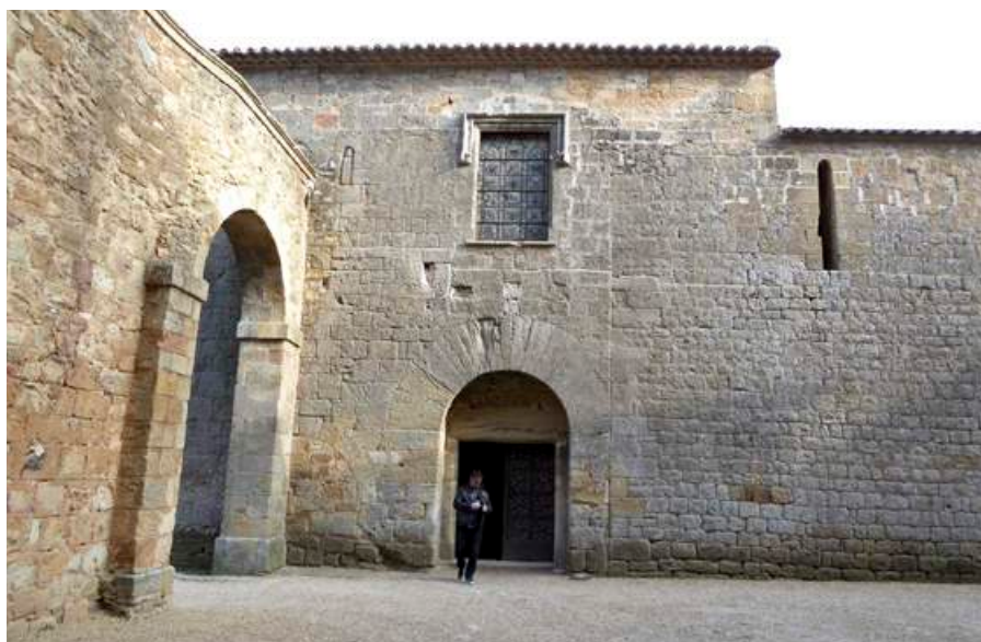
Fig. 20 : Vue actuelle de l'ancien accès médiéval au monastère. La porte ouvrant sur le réfectoire des convers est murée. Celle du monastère est ouverte. À noter, la toiture de l'aile des convers qui se prolonge sur celle du cellier, au-delà de la chaîne d'angle.
