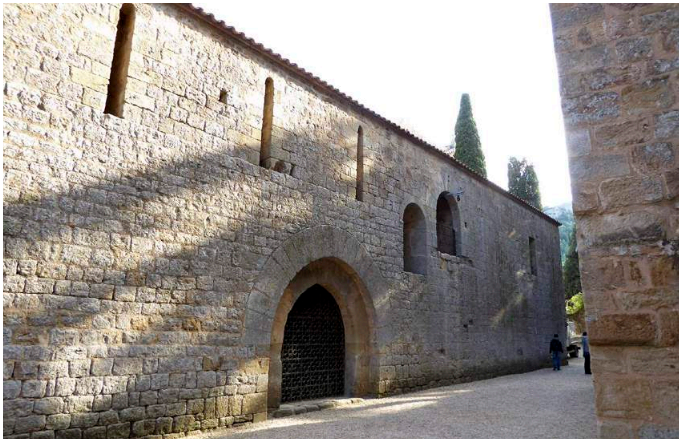
Fig. 7 : Vue de la façade occidentale du cellier. Le grand portail cocher médiéval est en partie enterré dans la rehausse des sols du XVIII e siècle. À noter, à gauche, les lancettes étroites éclairant l'étage et à droite, les portes du grenier à l'étage.
