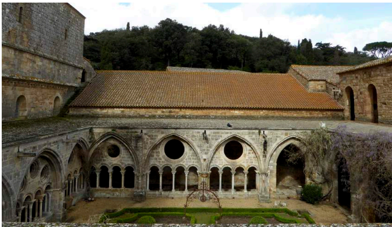
Fig. 6 : Vue générale depuis la terrasse est du cloître montrant la couverture du versant est du cellier qui se poursuit sur la voûte de la ruelle des convers. À gauche, l'escalier rampant sur les voûtes de l'allée et du cellier qui dessert la salle du trésor.
