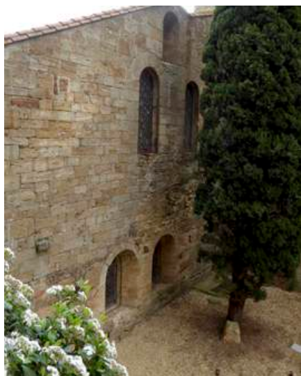
Fig. 8 : Vue latérale du pignon sud en partie masquée par un cyprès montrant le désaxe des baies jumelles du rez-de-chaussée et de l'étage, ainsi que la baie haute partiellement murée dans la salle haute.
