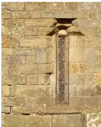
Fig. 9 : Détail de la baie ébrasée jouxtant la façade de l'abbatiale. À noter, la rupture de l'alignement des assises de l'appareil à gauche de la baie.
