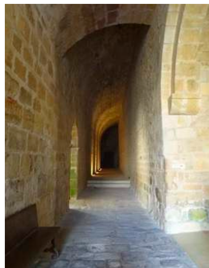
Fig. 17 : Vue de la ruelle des convers conduisant à l'église. Le cloître est situé à gauche, tandis que la façade est du cellier reçoit la demi-voûte de la ruelle des convers. Le culot, au premier plan, porte le palier d'étage de l'escalier d'honneur.
