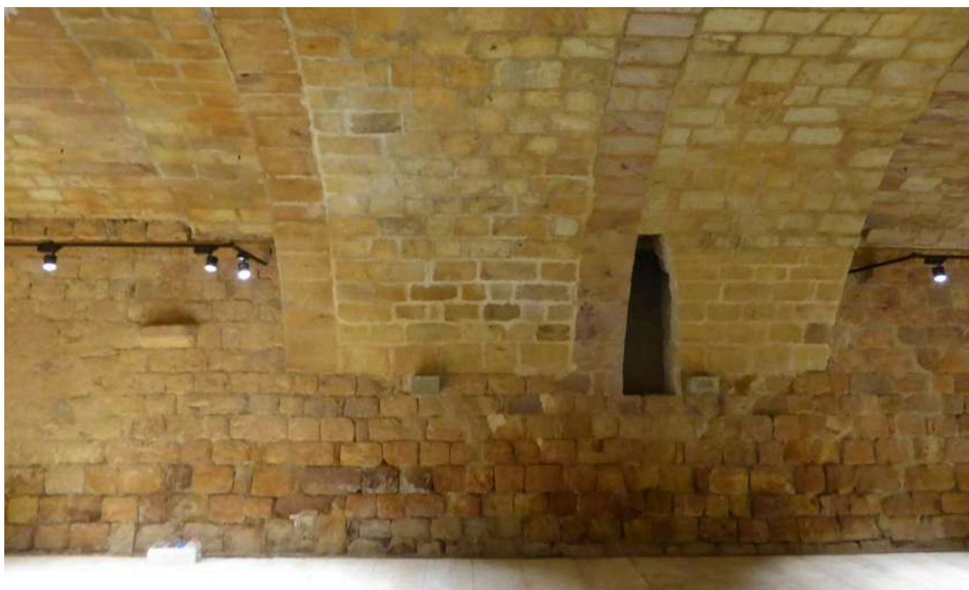
Fig. 28 : Vue de l'accès à l'escalier bâti dans l'œuvre du mur est du cellier et son intégration dans le voûtement de la salle basse.
