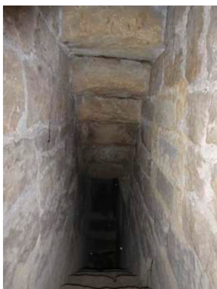
Fig. 27 : Vue depuis le haut de la montée nord de l'escalier bâti dans l'œuvre du mur est du cellier.
