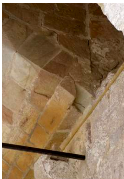
Fig. 11 : Vue depuis le sud de la salle basse du cellier montrant les différents types de voûtements juxtaposés dans ce volume.
